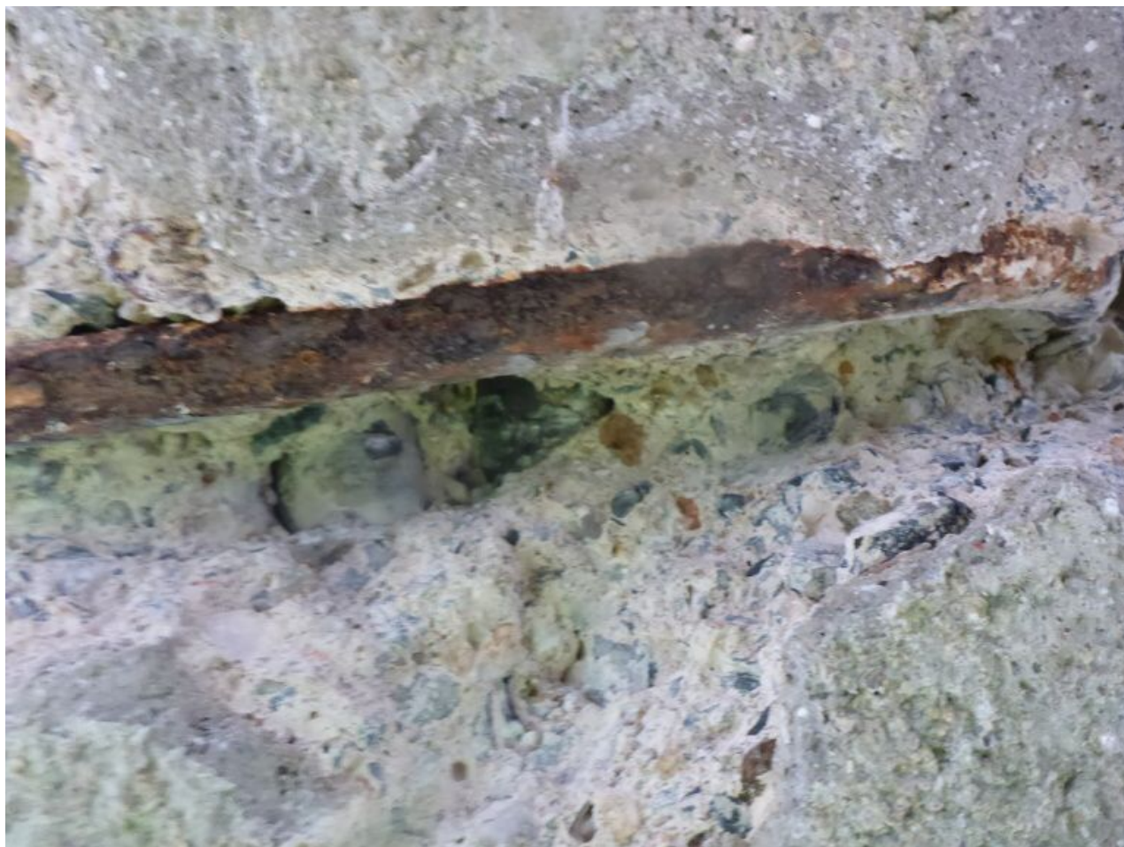
090 Sondy do nosné konstrukce mostu
