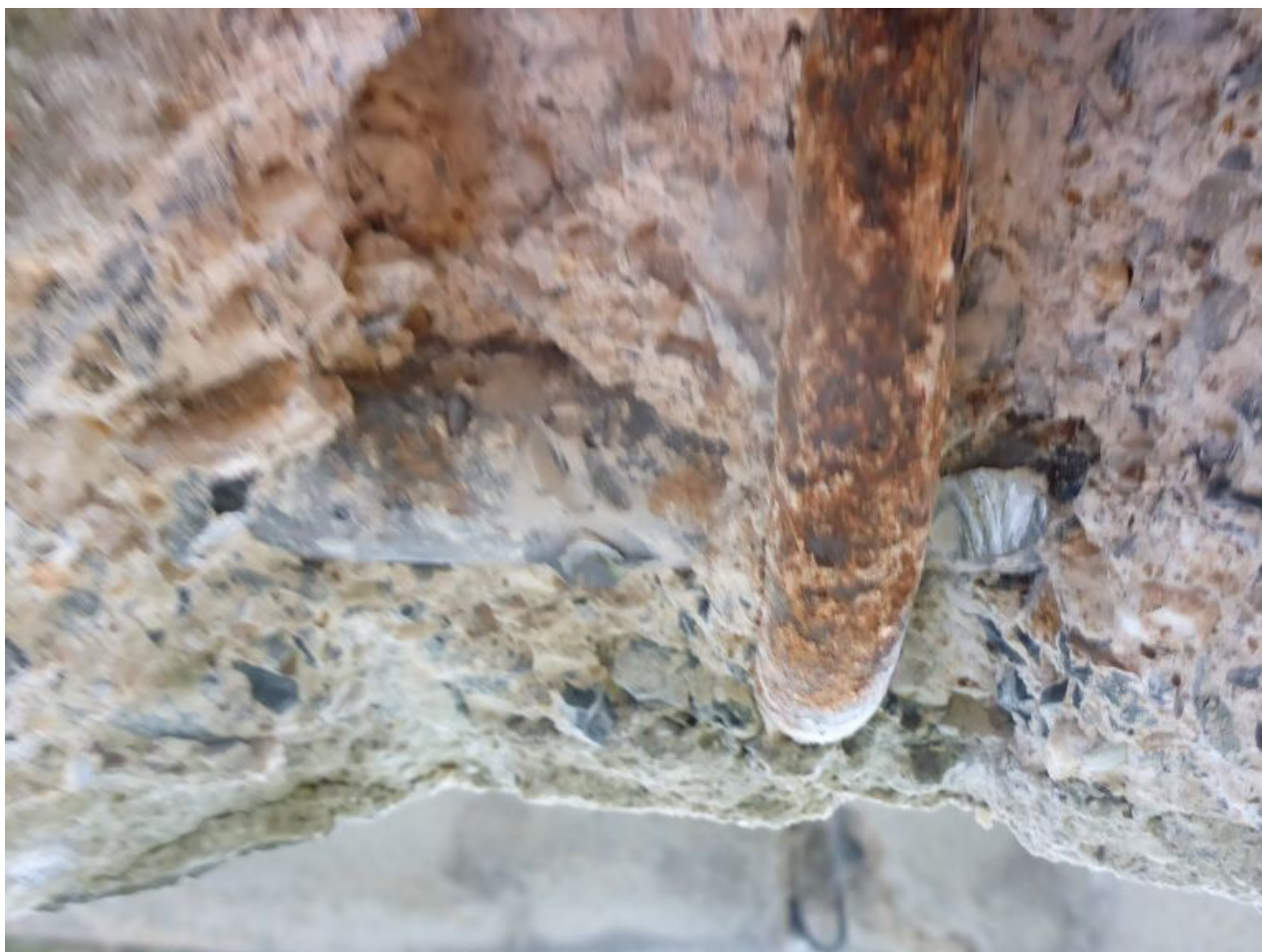
095 Sondy do nosné konstrukce mostu
