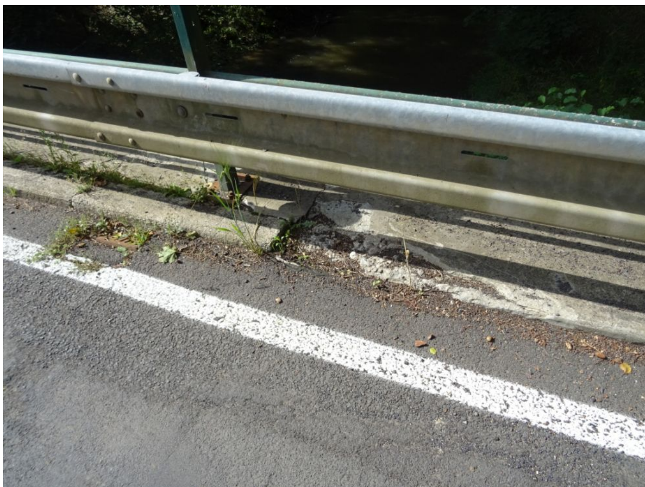
022 Poruchy římsy na návodní straně
