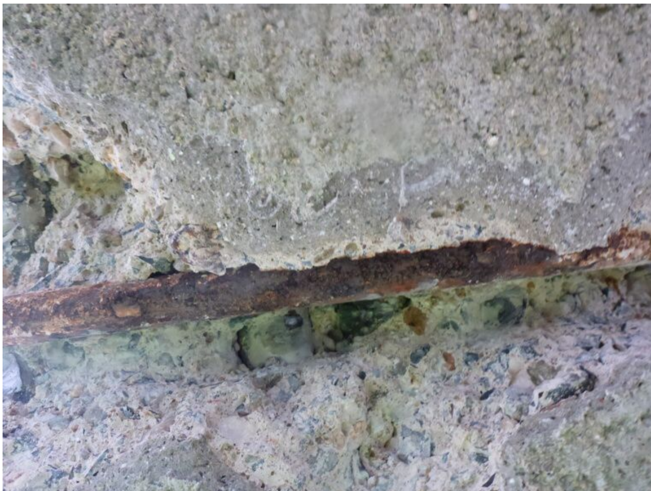
094 Sondy do nosné konstrukce mostu
