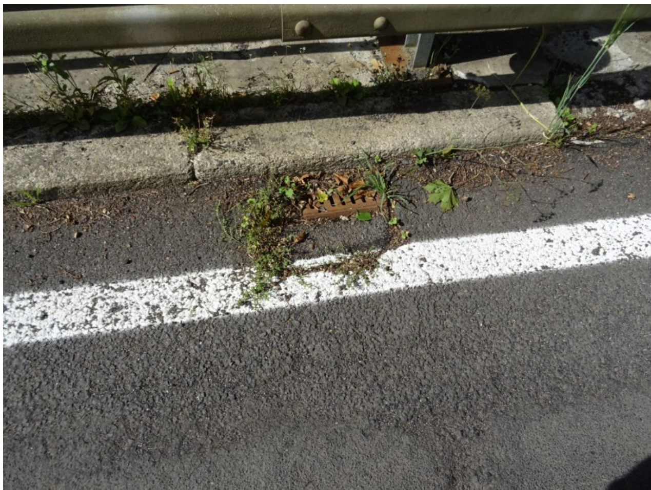
023 Odvodnění mostu
