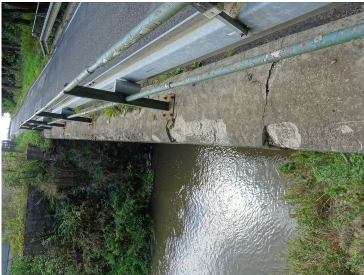
017 Poruchy římsy na povodní straně
