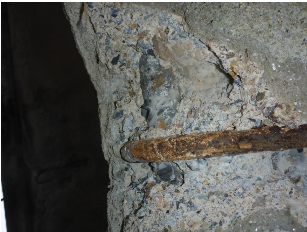
093 Sondy do nosné konstrukce mostu
