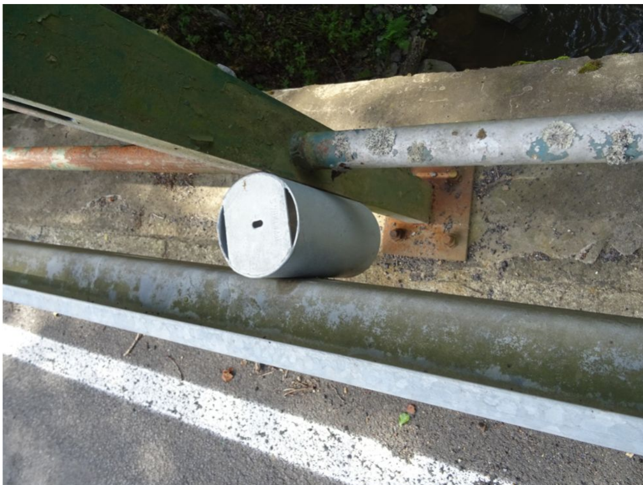
024 Kotvení zábradelního svodidla
