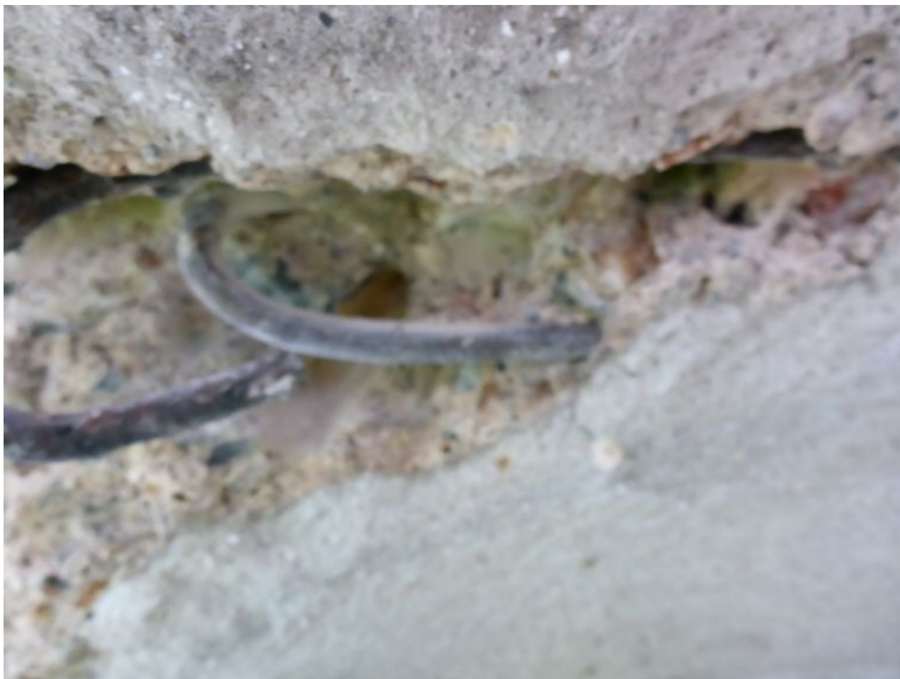
084 Sondy do nosné konstrukce mostu
