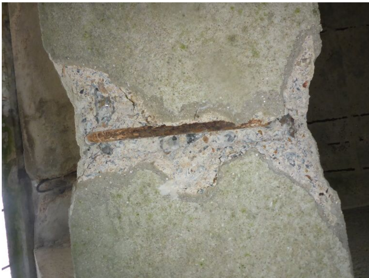
097 Sondy do nosné konstrukce mostu
