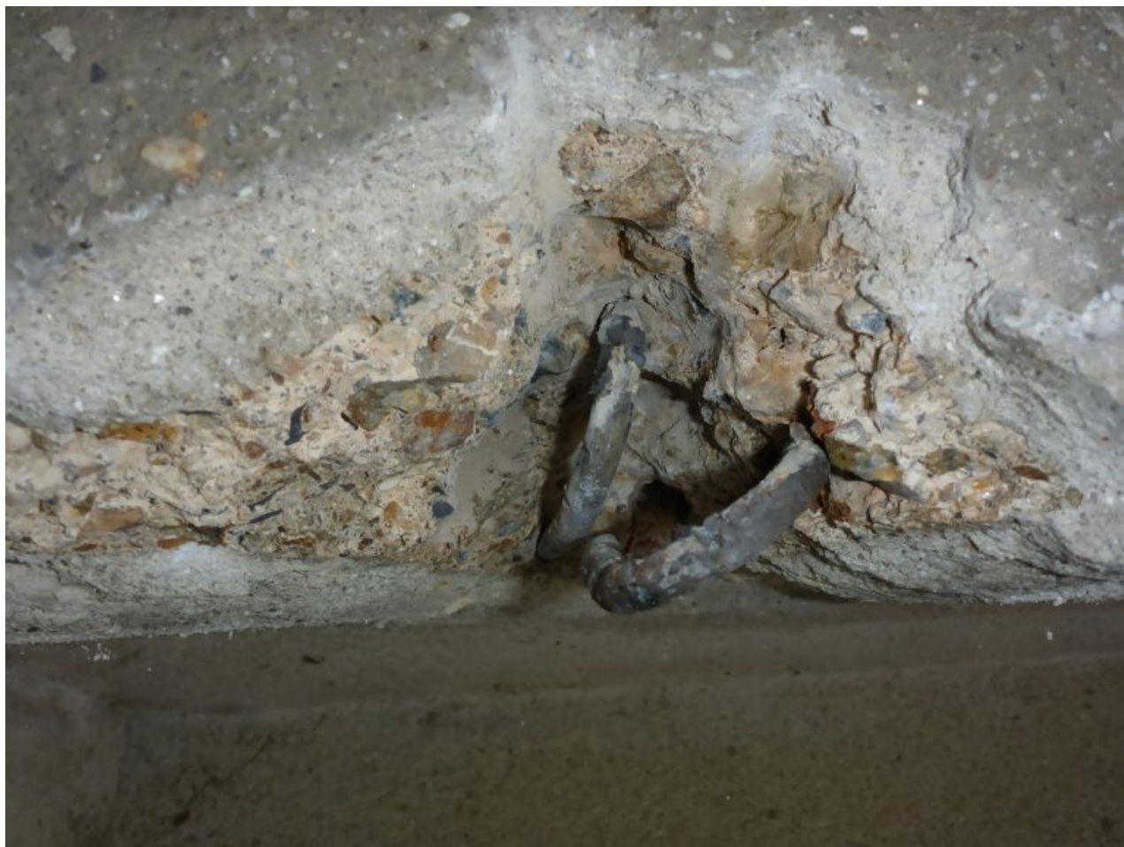
082 Sondy do nosné konstrukce mostu
